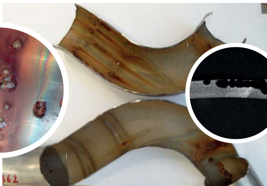
Grande photo: tube ouvert en inox 316L. Pustules de corrosion brunes sur les soudures. La conduite montrait des fuites dues à la MIC. Remarquez aussi les modèles de taches brunes consécutives à l'écoulement dans la conduite. Photo incrustée de gauche: vue sur l'intérieur d'une soudure en inox 316L. Taches de corrosion brunes sur et à côté de la soudure. Photo incrustée de droite: coupe métallographique de la soudure en inox qui a échoué à cause de la MIC. Remarquez l'attaque en forme de tunnel sous la surface
