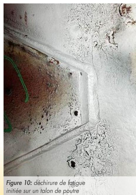
**Figure 10:** déchirure de fatigue initiée sur un talon de poutre
