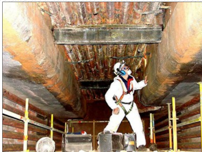
Photo 1: On peut prendre des répliques dans des espaces confinés (comme dans un four). Trois sacs de travail doivent être emportés dans le four pour examiner des aciers au carbone. La zone de réplique doit être accessible à l'œil nu
