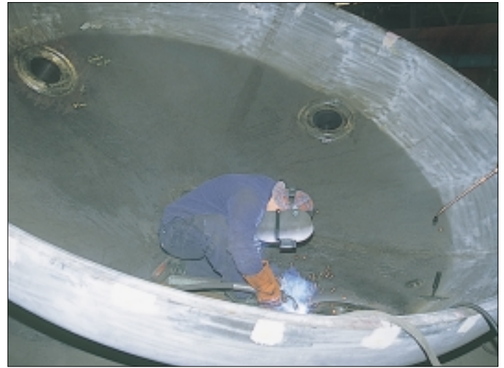
Tip voor het verkrijgen van een lasverbinding zonder waterstof-geïnitieerde scheurvorming: pas een laag waterstofhoudend proces toe.
